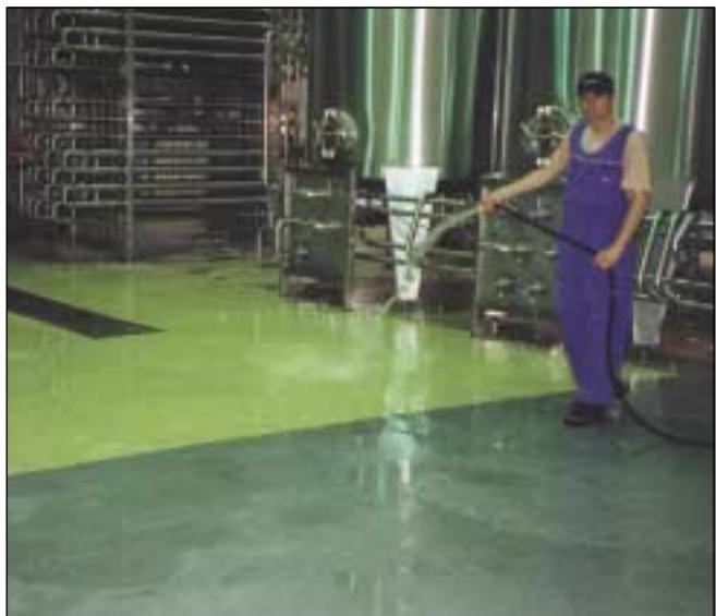
Материал наносится толщиной 4 - 6 мм, поставляется в любых цветовых комбинациях. Раствор может быть утрамбован механически, после высыхания легко очищается.
