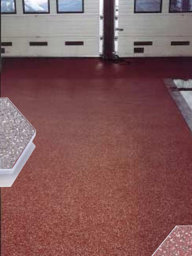
бесшовное покрытие с высокой механической и химической стойкостью. Толщина напольного покрытия 2-3 мм с гладкой поверхностью или 4 - 5 мм с шероховатой нескользкой поверхностью.
