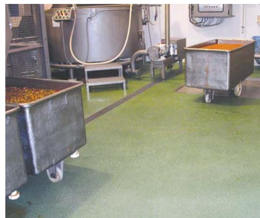
*Метилметакриловое покрытие Duracop толщиной 10 мм, консервный завод BUSS в г. Бремен (Германия), 25 лет в эксплуатации!*
