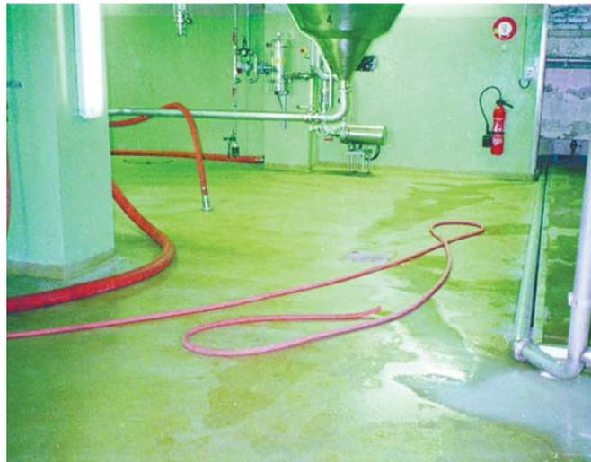
связующего с кварцевым наполнителем, фракция которого оптимизирована в специальных лабораториях. После полной полимеризации (через 7 сут) акрил-цементное покрытие MONILE® становится водостойким, нескользким, отличается не только высокой прочностью и стойкостью к эксплуатационным нагрузкам, но и устойчивостью к воздействию кислот и других химических соединений, применяемых в пищевой промышленности, а также сохраняет постоянство своих ха-
