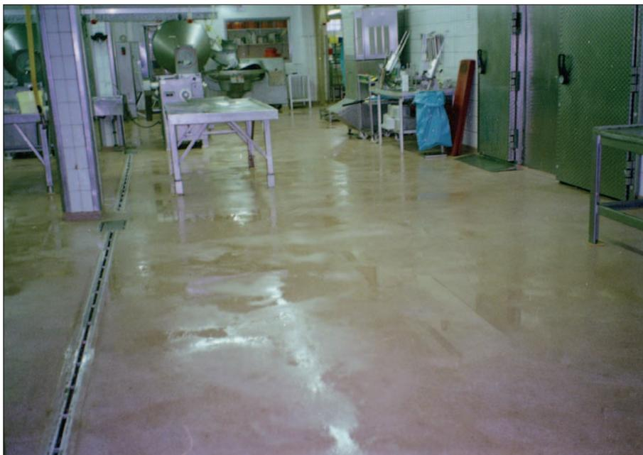
Полиуретан-цементное покрытие Duracop толщиной 6 мм, 8 лет в эксплуатации, перерабатывающий завод EFA (Люксембург)
