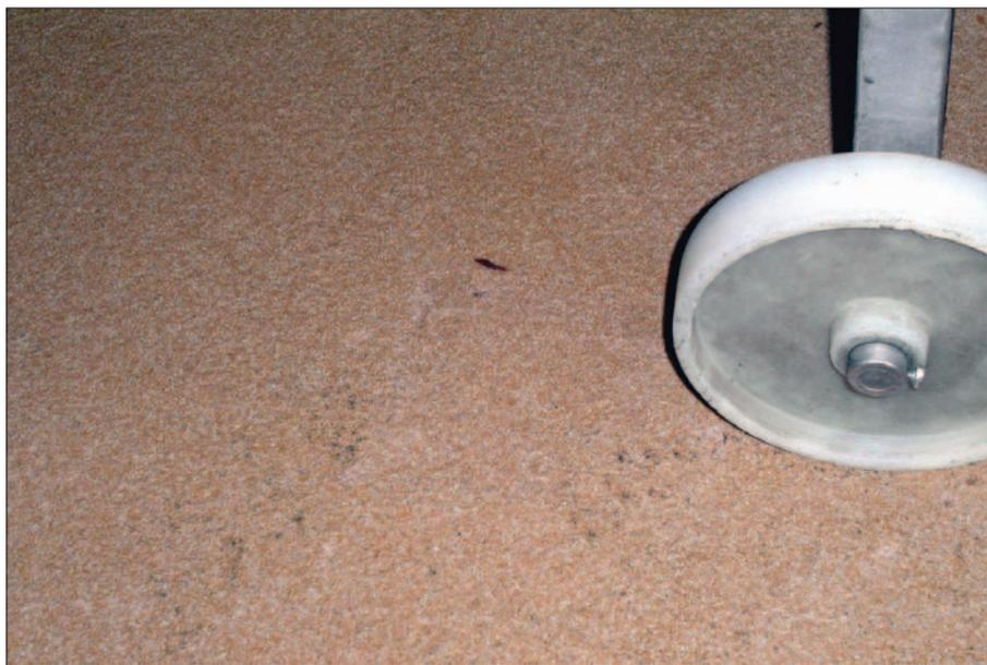
Метилметакриловое покрытие Duracop толщиной 10 мм, 25 лет в эксплуатации, консервный завод BUSS (Бремен, Германия)
