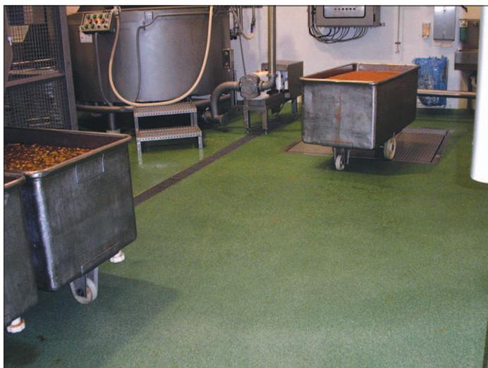
Метилметакриловое покрытие Durakon толщиной 10 мм, 25 лет в эксплуатации, консервный завод BUSS (Бремен, Германия)
